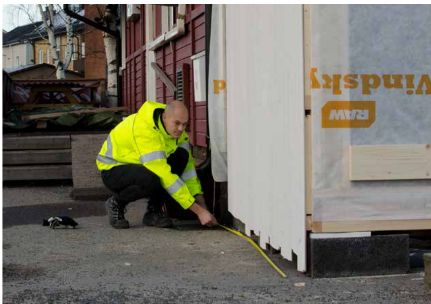
Stefan Eriksson, byggnadsinspektör, i arbete med att mäta utbyggnad.
